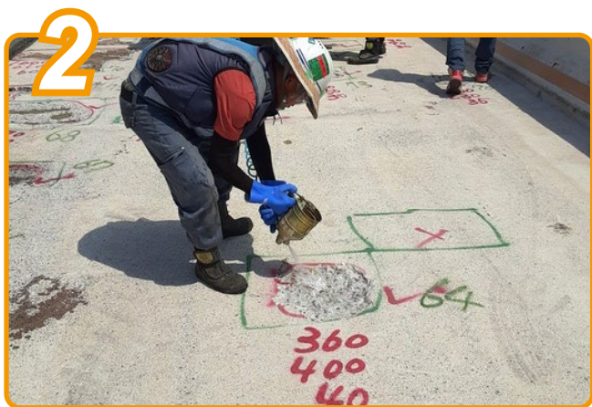
浸透性エポキシ樹脂接着剤塗布
