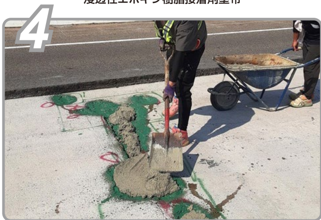
上面補修材打設
