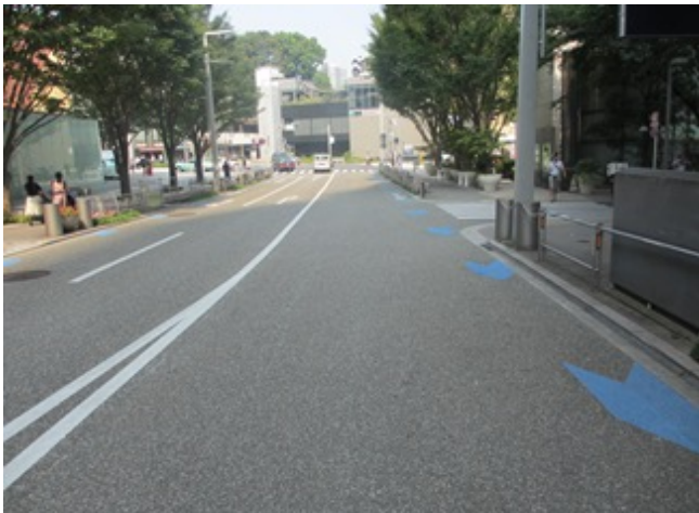
天然骨材を使用した自然色舗装
