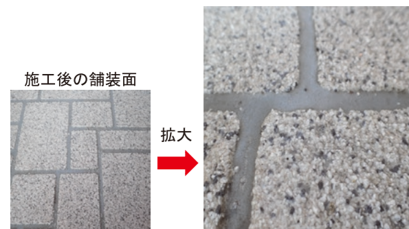
※目地部分に骨材が固着しない工法です。
