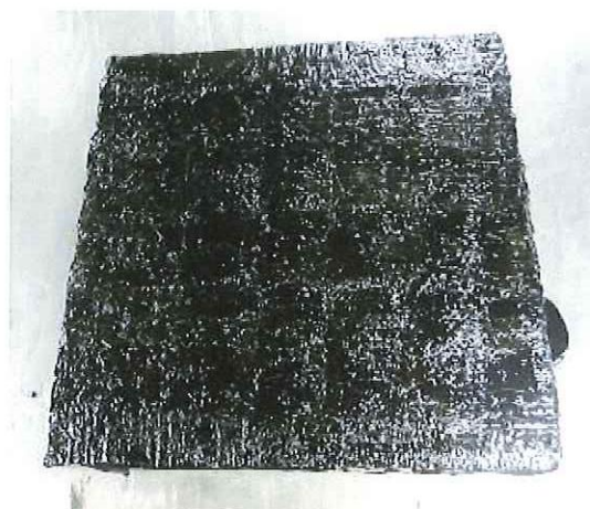
防水層施工完了
