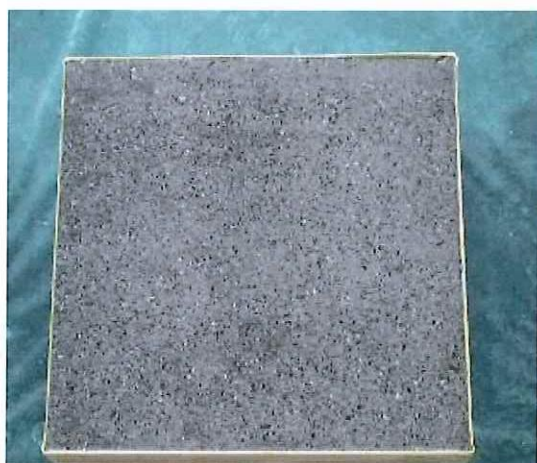
プライマー塗布完了状況
