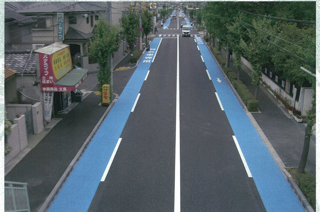
排水性舗装表面強化
