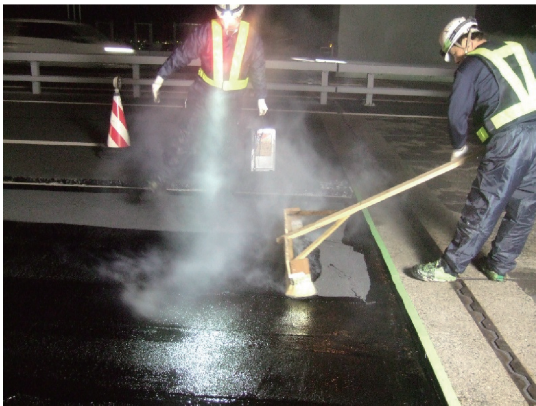
現場施工状況 防水層
